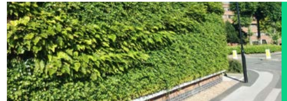
Enhance blank façades
